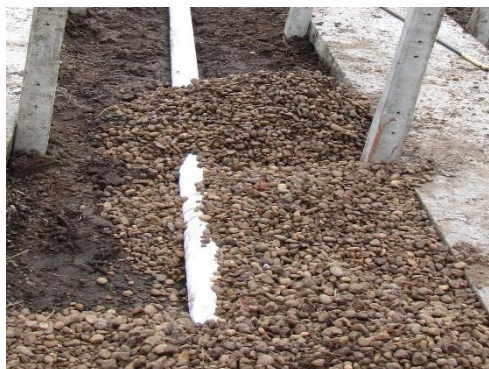
Figura 2: Caminos de hormigón y área bajo las mesadas con caños perforados para desagüe y canto rodado lavado.
