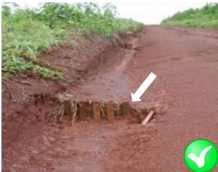
Figura 2: Detalle de dissipadores de energía en cunetas de desagüe prolongadas y con pendientes.
